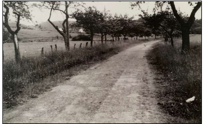
Die alte Straße vor der Verlegung
