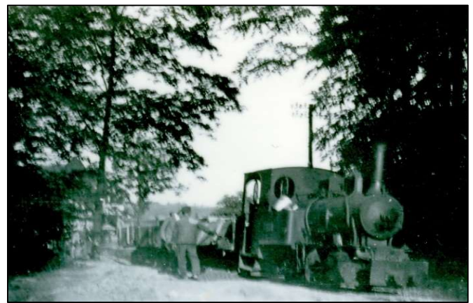
Für den Transport der Erdmassen kam die Eisenbahn zum Einsatz
