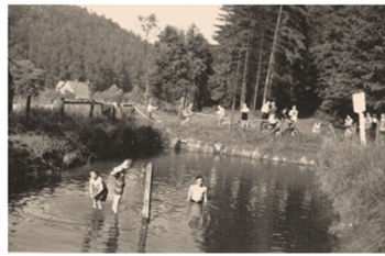
Bis ca. 1950 gab es unweit von hier eine Badeanstalt am Auebach
