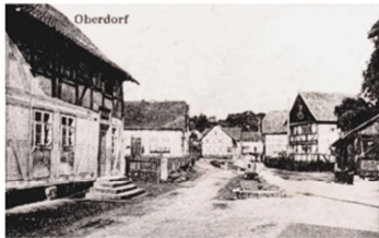
Der Auebach floss vor 100 Jahren offen durch das Oberdorf
